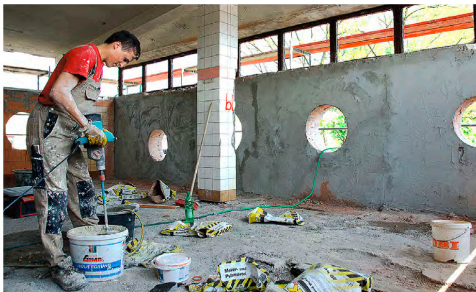
Une charte éthique pour des constructions exemplaires.
